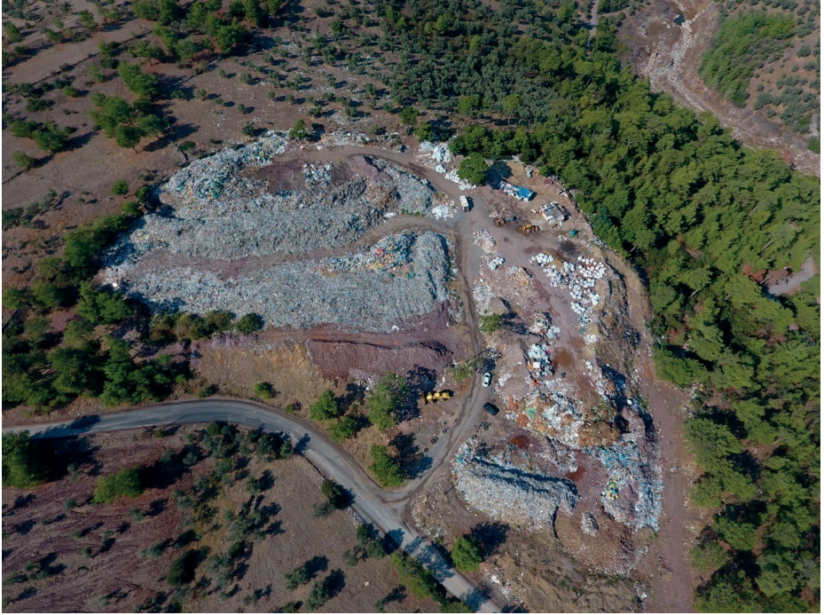
Resim 15.Mumcular Vahşi Çöp Depolama Sahası Rehabilitasyon Öncesi
