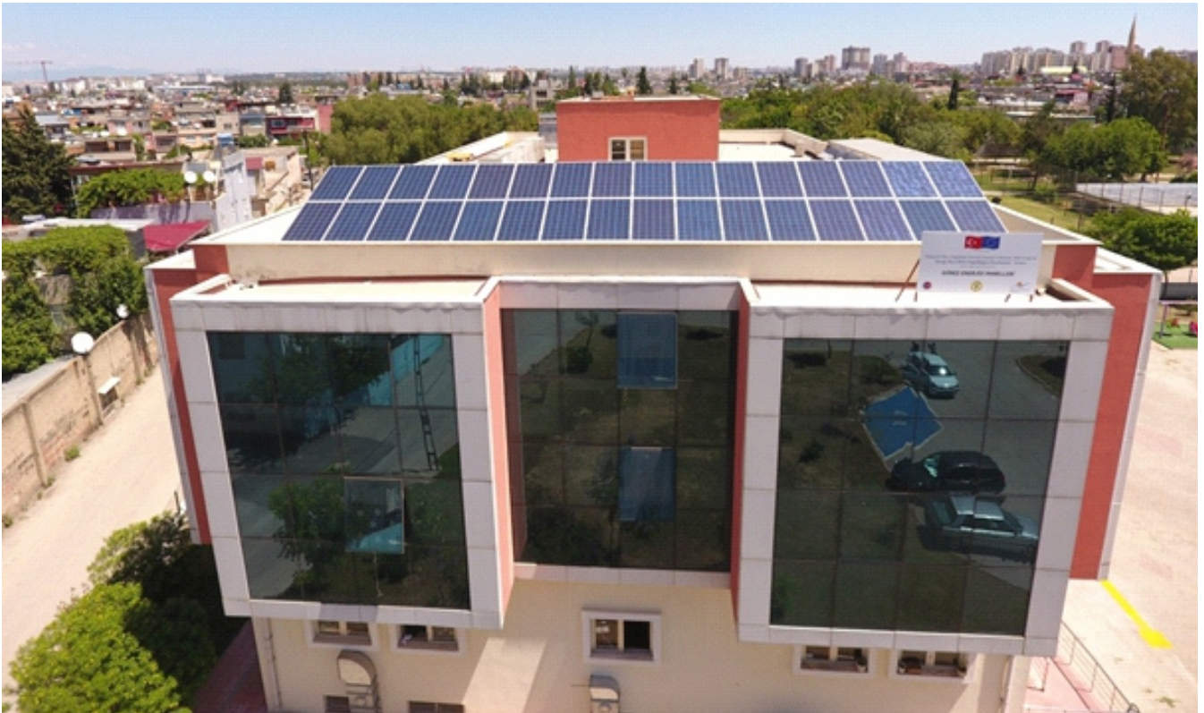
Resim 5: Yüreğir Belediyesi Güneş Paneli Uygulaması
