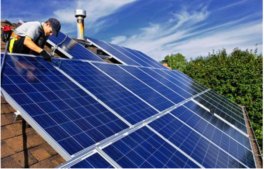
Resim 35:Çatı Tipi GES Projesi (Temsili)
