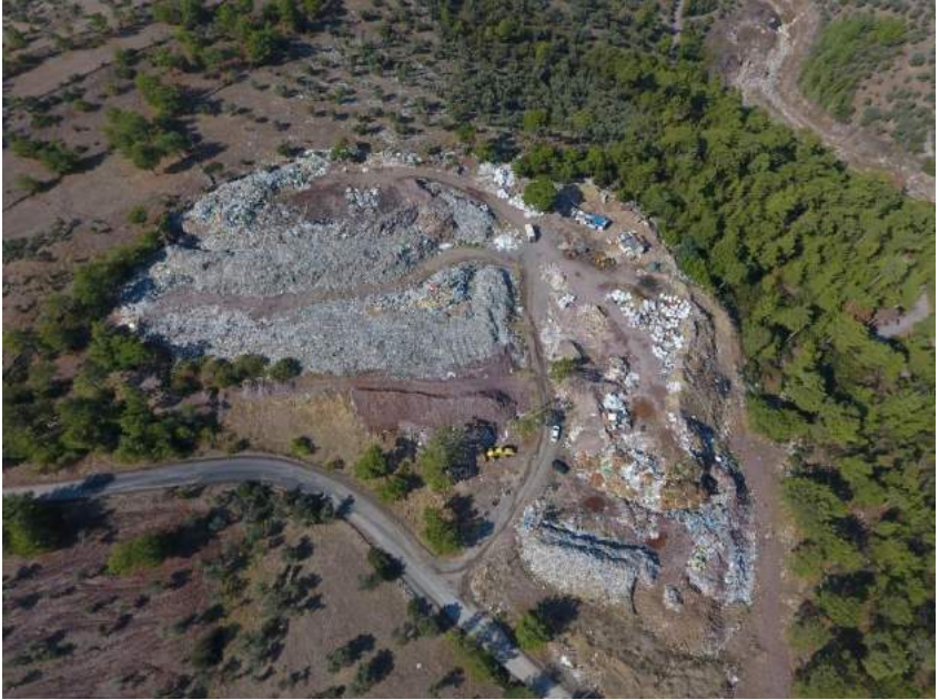
Resim 15.Mumcular Vahşi Çöp Depolama Sahası Rehabilitasyon Öncesi
