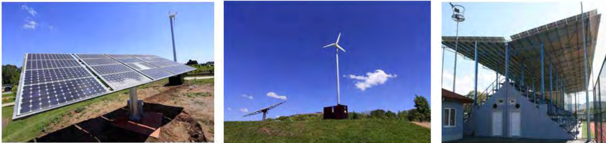
Şekil 16 - Sekapark ve Doğu Kışla Parkı Rüzgar Türbini ve Güneş Paneli Uygulamaları (KBB, 2018c)
