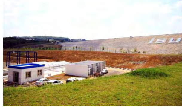
Kandıra Namazgâh Barajı Hidroelektrik Santrali (HES)
