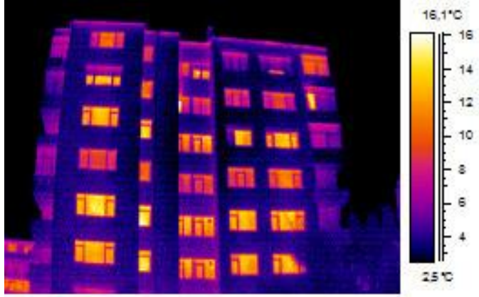
Yalıtımlı Bina (sonrası)
