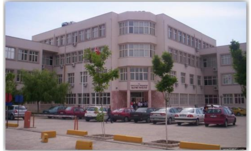
FOTOĞRAF 2: İşletme Fakültesi Binası
